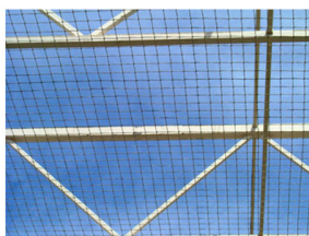
Filet de protection Conforme à la norme EN-1263-1
